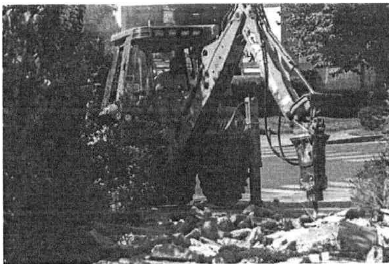
Премахване на съществуващи настилки
